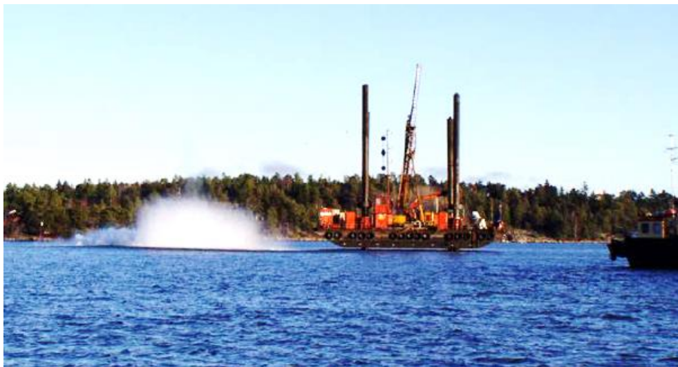
Figur 13. Undervattenssprängning med borrhög
