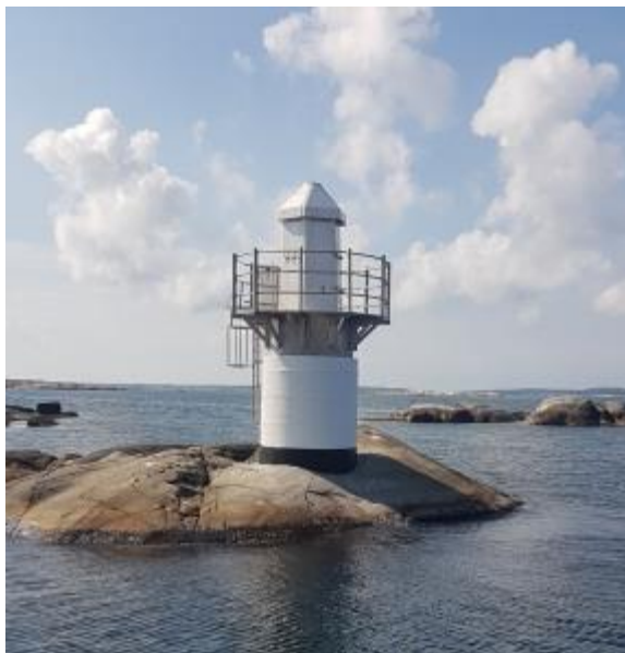
Figur 17. Exempel på nybyggt kummel (utanför Strömstad)
