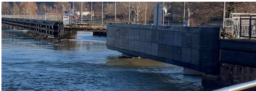
Figur 4. Östra slussinfarten (uppströmssidan) med fendrar och ledverk utanför den marina rastplatsen i bakgrunden.
